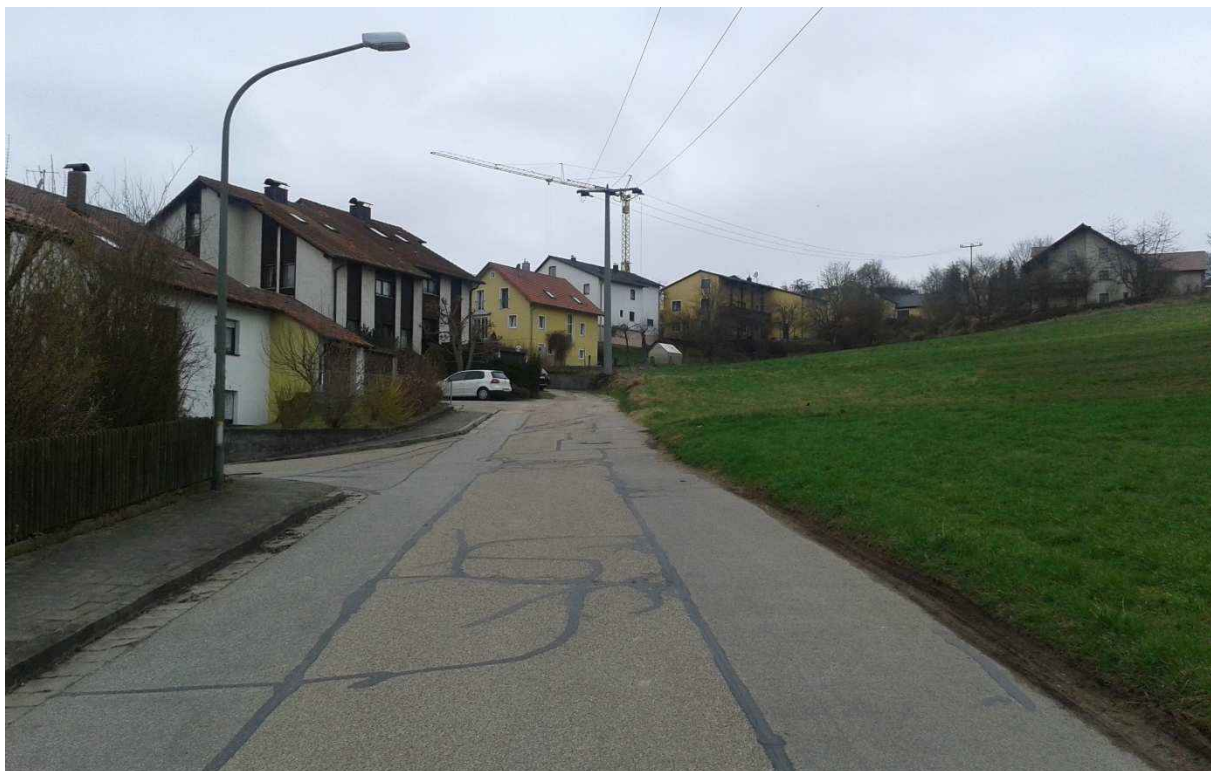
Blick auf den (offenen) Gebrachinger Weg Richtung Westen mit Stromfreileitung, rechts: geneigte Änderungsflächen
