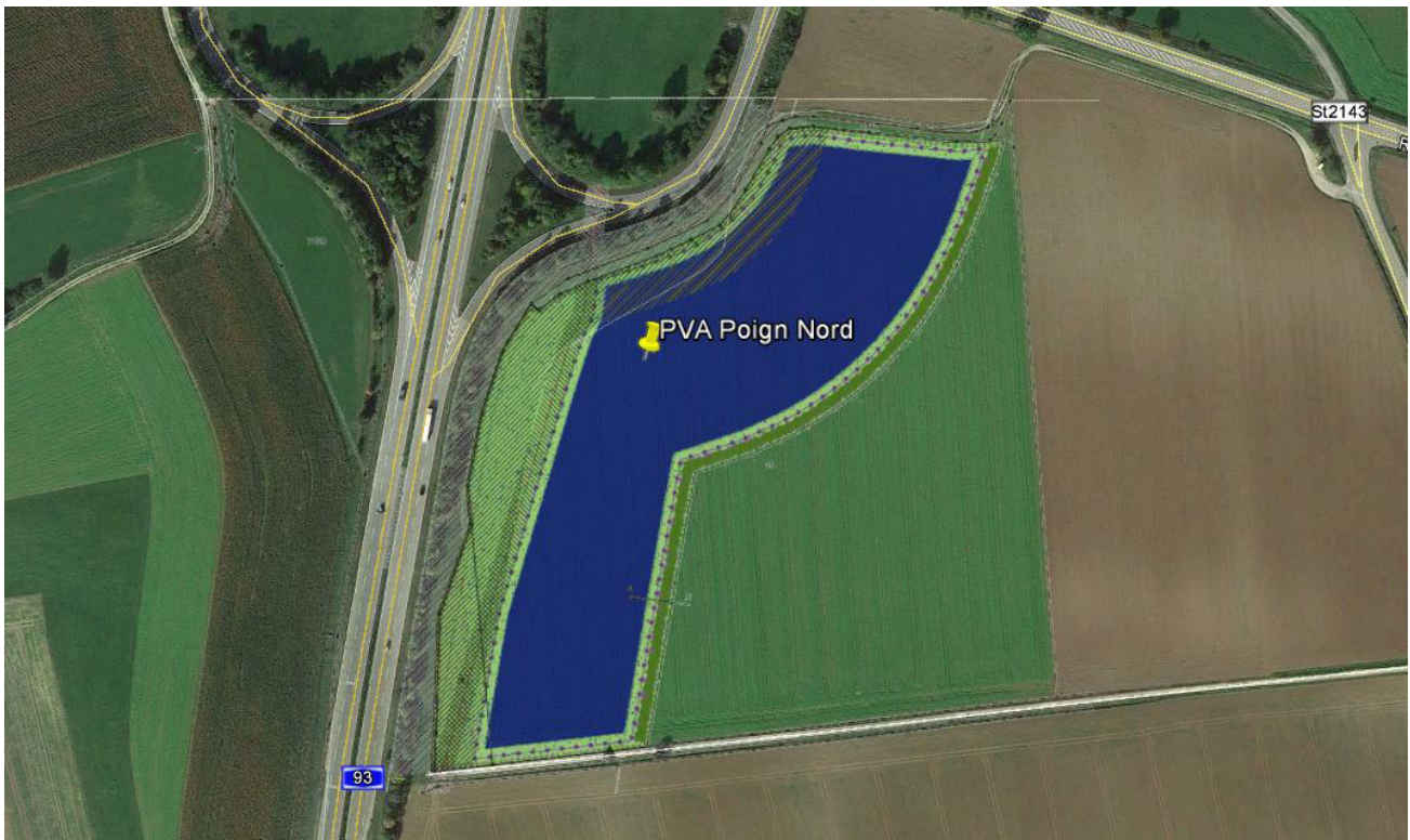
Bild S2: Detailansicht der PV Anlage Nord (Quelle: Google Earth/SolPEG)
